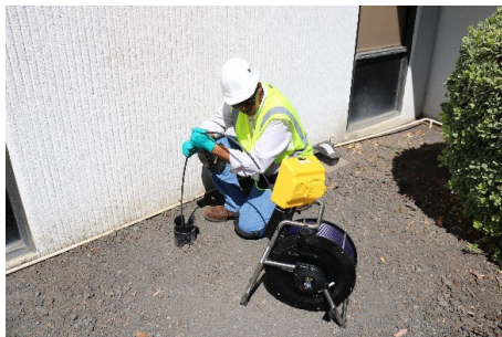
Bei unsachgemäßem Einschieben kann das Schubkabel geknickt werden.
